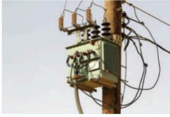
■ الشكل 17-1 تستخدم المحولات الخافضة للتقليل من الجهود الكهربائية الكبيرة في خطوط نقل القدرة إلى مستويات تناسب المستهلكين في أماكن الاستخدام.
